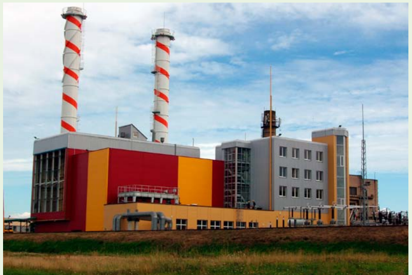
Demonstracinė termofikacinė elektrinė Panevėžyje
