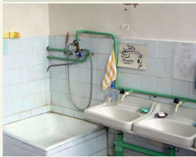
Darželiai laukia renovacijos darbų.
